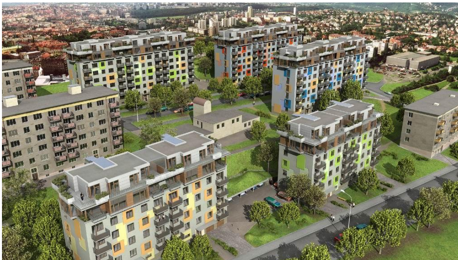
Obrázok 1 Pohľad na obnovený komplex bytových domov (SKM Praha 3, a.s., 2009)
