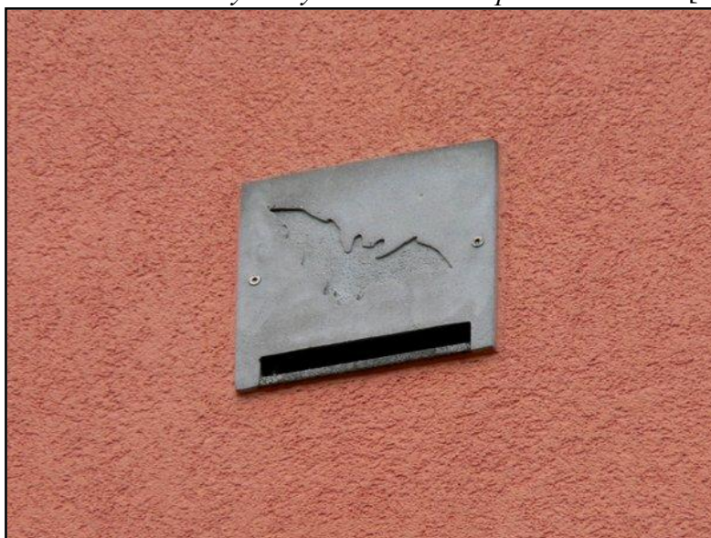
Obr. č. 9: Príklad operatívneho zásahu – osadenie búdok netopierov na fasádu s ETICS. Bytový dom Banská Bystrica [10].
