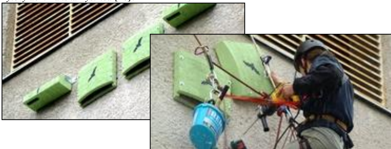
Obr. č. 9: Príklad operatívneho zásahu – osadenie búdok netopierov na fasádu s ETICS. Bytový dom Banská Bystrica [10].
