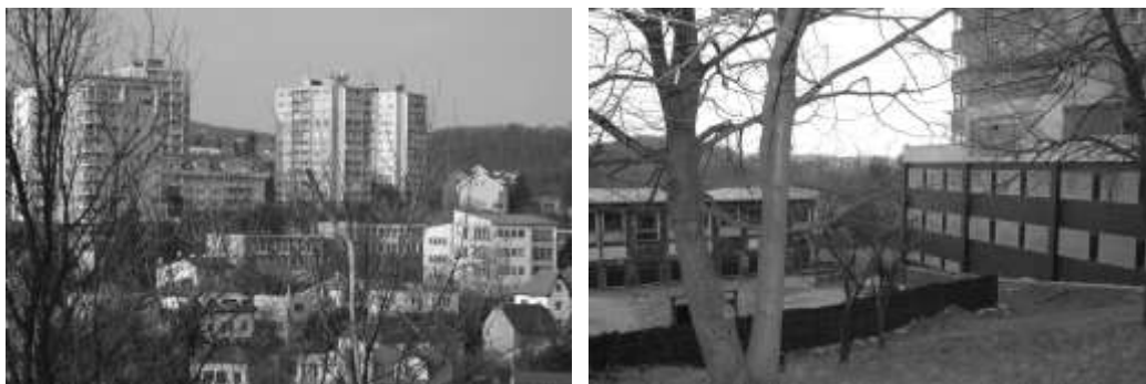
Obr. 4 Výstavba nového obytného domu, Kramáre, Bratislava (Zdroj: archív autora 2013)
