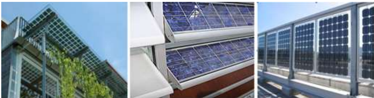
Obr. 4 Príklady integrácie FV modulov do prídavných prvkov fasády (markízy, tieniace systémy, zábradlia..)
