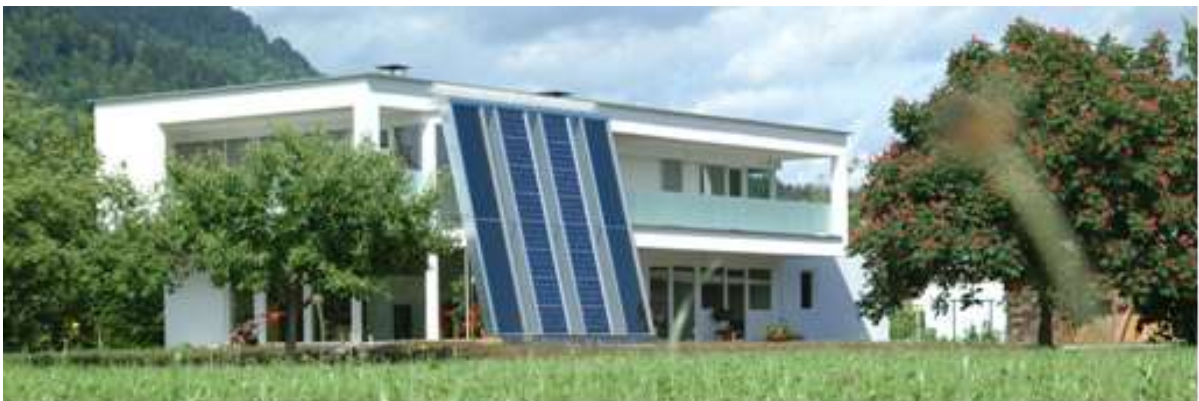
Obr. 3 Príklady použitia FV modulov na fasáde objektu
