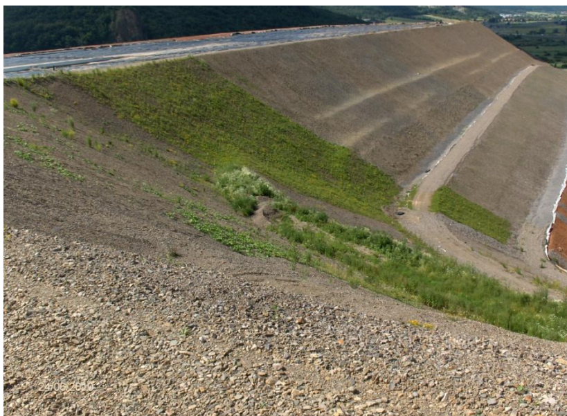
Obr. 4 Stav prác na utesňovaní odkaliska v Žiari nad Hronom z 24.6.2010 (foto Hulla).
