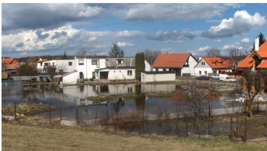
Obr. 5 Stavebné objekty pri vzdušnej päte ľavobrežnej hrádze Moravy počas povodne v roku 2006 (foto Hulla).
