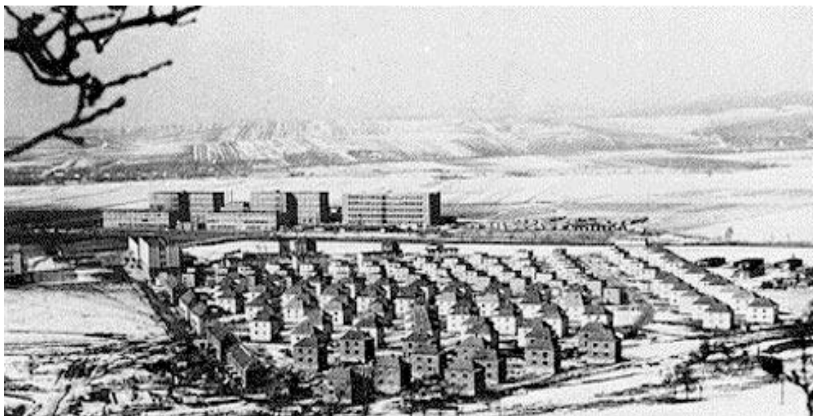
Obr. 2 Pohľad na Ba ovany – Partizánske krátko po výstavbe (1939)
