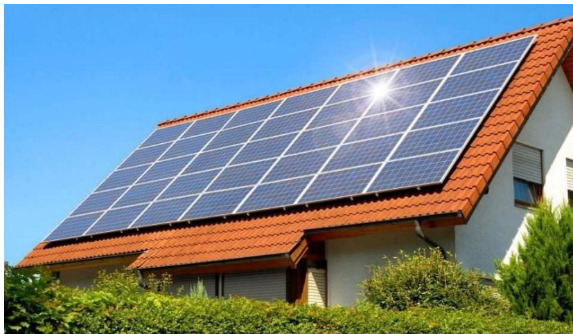
Obr. 3.15 BAPV systém na streche rodinného domu [28]
