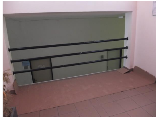
Obr. 34. Zábradlie na schodiskovej medzipodeste
