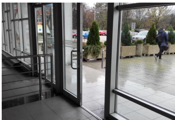
Obr. 4. Dlažba pred hlavným vstupom
