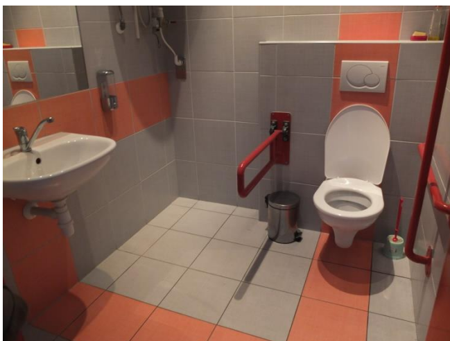
Obr. 29. Bezbariérová záchodová kabína
