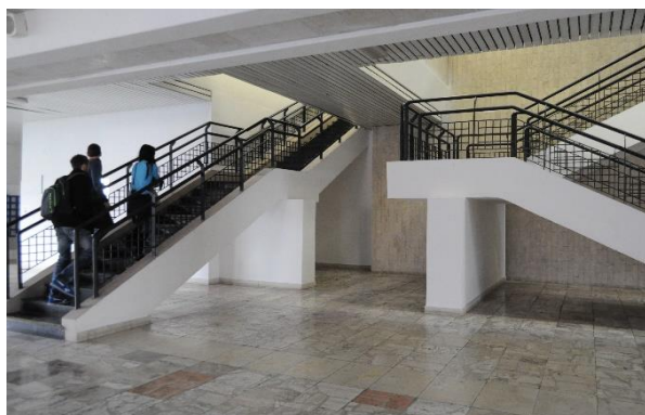
Obr. 12. Prístup do jedálne Ekonomickej univerzity v Bratislave je len schodiskom
