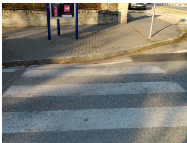
Obr. 1. Priechod pre chodcov bez nájazdovej rampy pri UKF v Nitre
