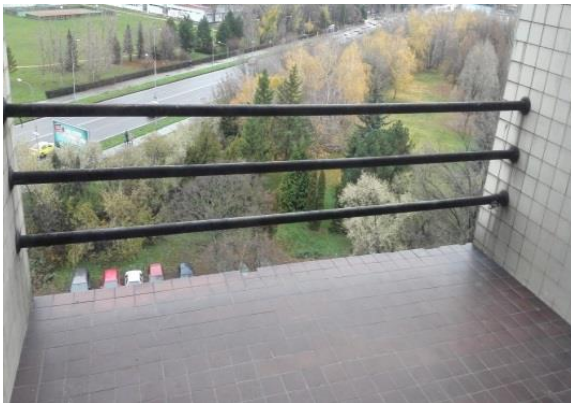
Obr. 33. Zábradlie na loggii
