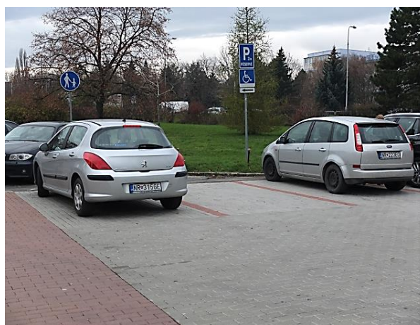
Obr. 2. Nedostatočné rozmery vyhradených parkovacích miest pri hlavnej budove SPU v Nitre
