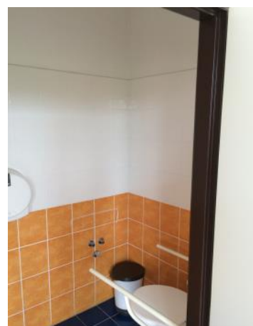
Obr. 6, 7. Nesprávne riešená bezbariérová záchodová kabína na Fakulte sociálnych vied a zdravotníctva UKF v Nitre
