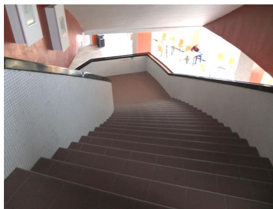
Obr. 17. Schodisko do auly SPU v Nitre zo vstupnej haly
