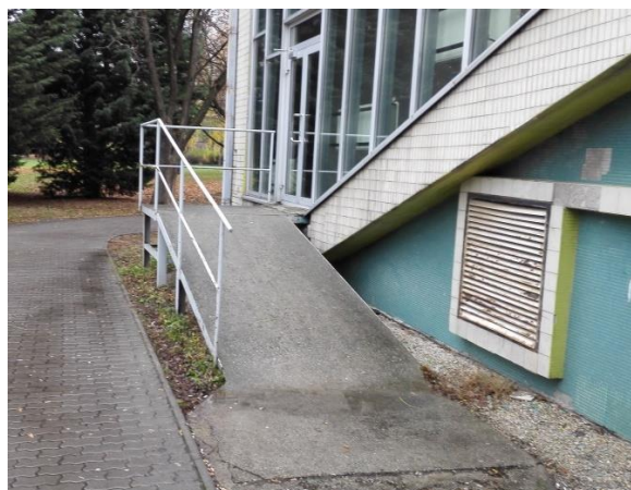
Obr. 6. Vedľajší vstup do auditória
