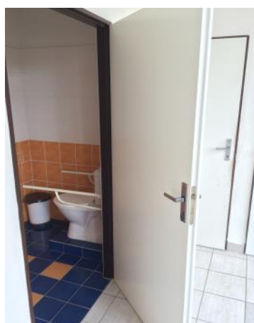
Obr. 6, 7. Nesprávne riešená bezbariérová záchodová kabína na Fakulte sociálnych vied a zdravotníctva UKF v Nitre
