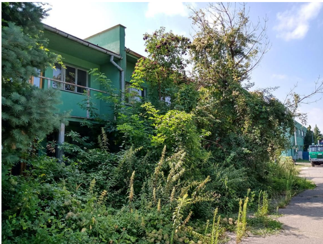
Foto 6: náletové dreviny v okolí budovy
