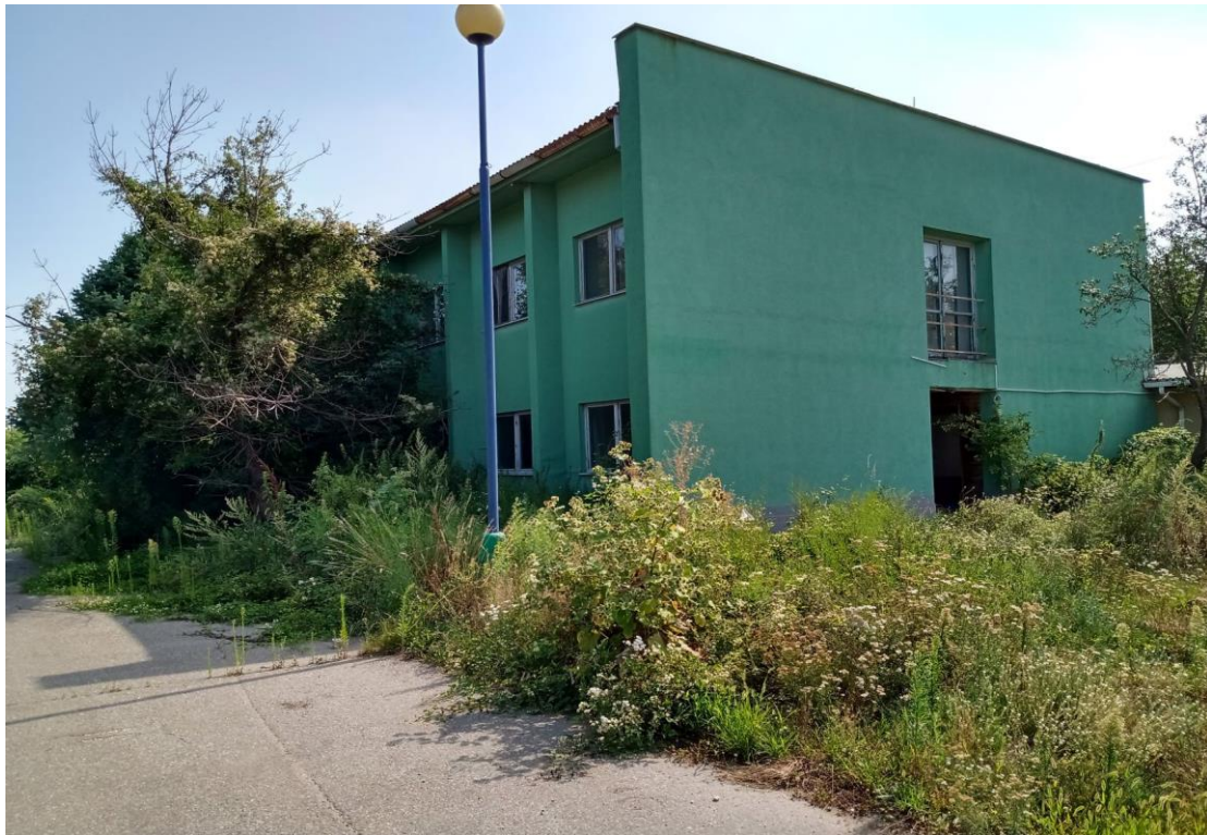
Foto 5: náletové dreviny v okolí budovy
