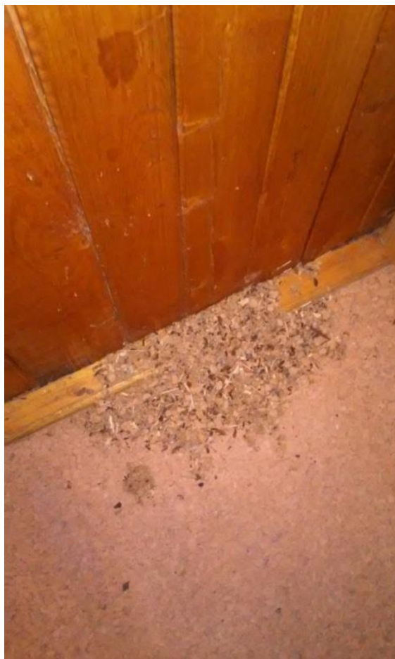
Príloha č.2 : fotodokumentácia poškodenia nosných drevených konštrukcií - UVZ Bezovec
