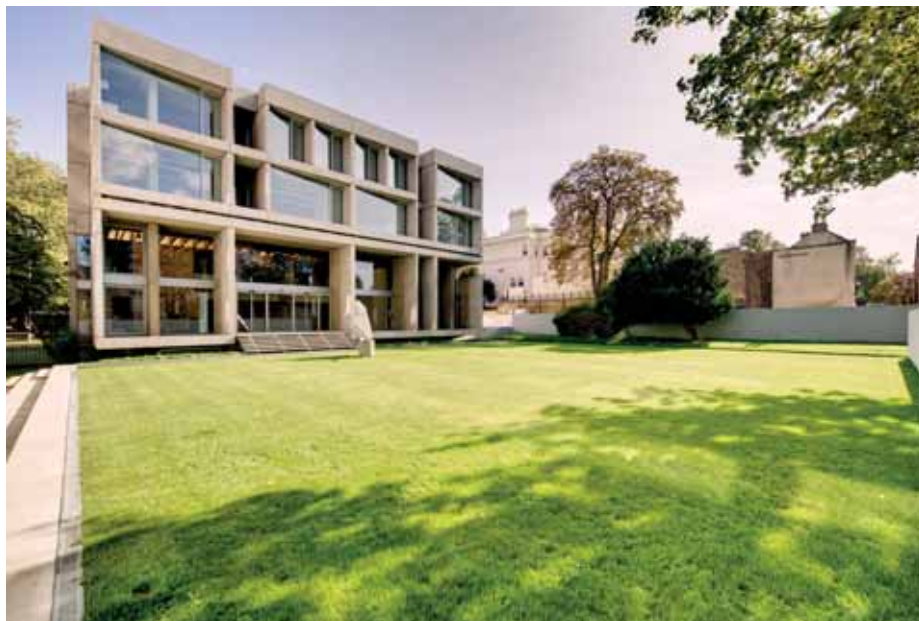
↑ Generálna rekonštrukcia ZÚ SR v Londýne, Spojené kráľovstvo, 2023.
