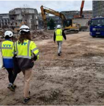
↑ Búracie práce Domu odborov Istropolis.
