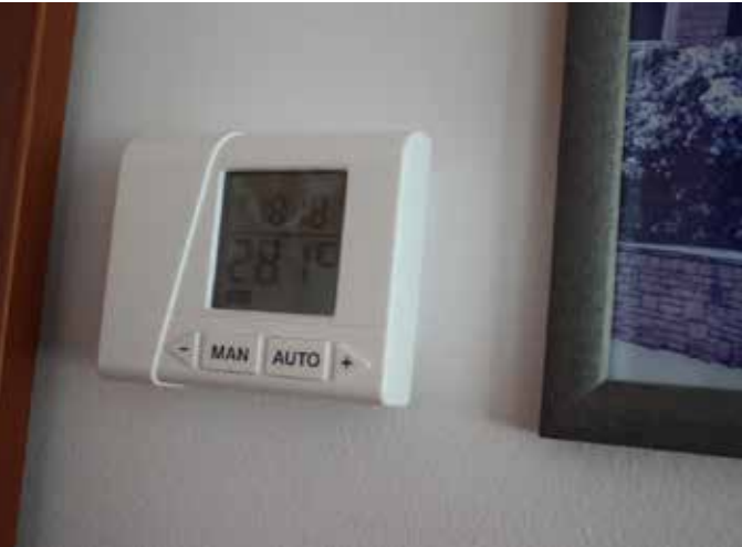
↑ Snímky znázorňujú praktické vyhotovenie (regulačná jednotka inštalovaná na stene v miestnosti – prvý obrázok, mechanické úpravy ventilov radiátora - príprava pre montáž radiacej hlavice, druhý obrázok).
