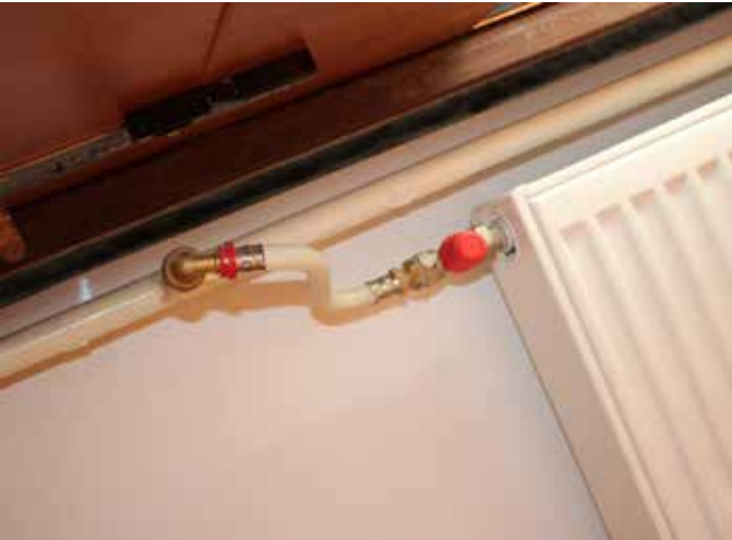
↑ Snímky znázorňujú praktické vyhotovenie (regulačná jednotka inštalovaná na stene v miestnosti – prvý obrázok, mechanické úpravy ventilov radiátora - príprava pre montáž radiacej hlavice, druhý obrázok).
