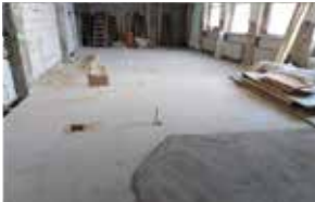
↑ Rekonštrukcia je v plnom prúde
