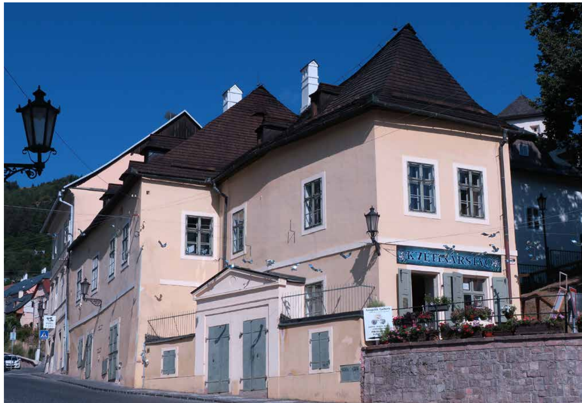
↑ Budova detašovaného pracoviska FAD STU v centre Banskej Štiavnice -- súčasný stav. Foto: Katarína Terao Vošková.
