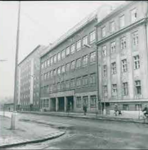
↑ Budova prístavby na Mýtnej ulici, od roku 1948 sídlo OSEI.
