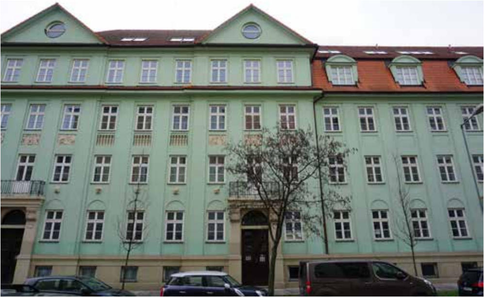
↑ Vydavateľstvo SPEKTRUM STU sídli v budove na Mýtnej v Bratislave.
