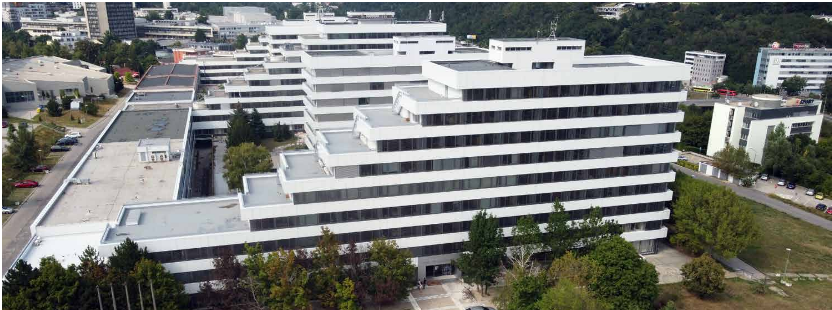
↑ Bloky FEI po rekonštrukcii
