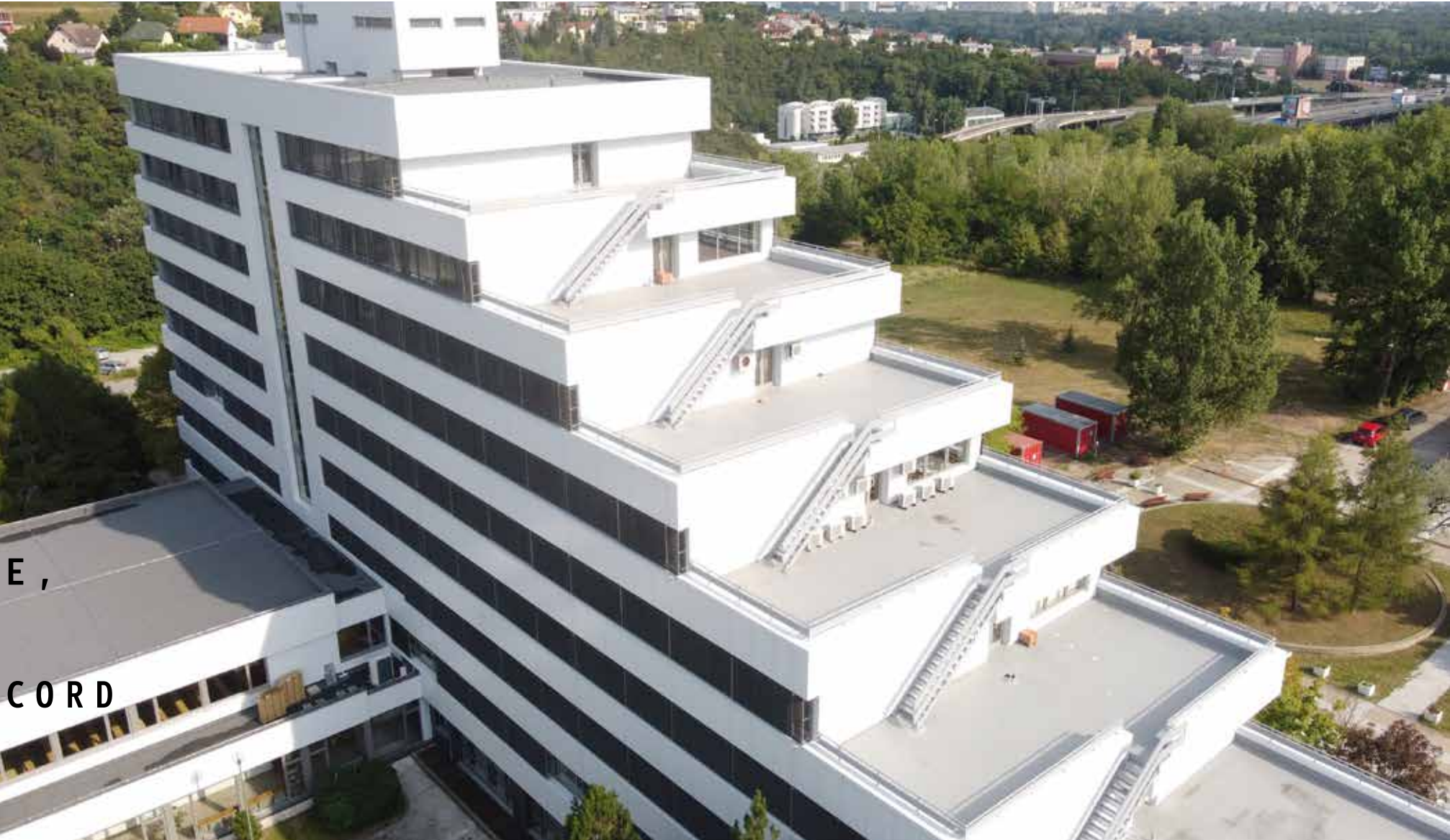
↑ Bloky FEI po rekonštrukcii
