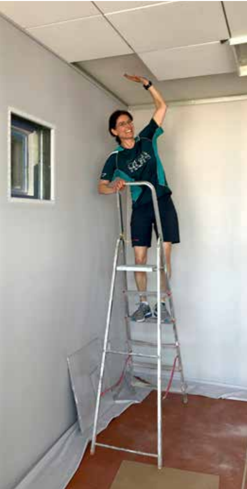
↑ Výstavba akustického laboratória na Stavebnej fakulte STU
