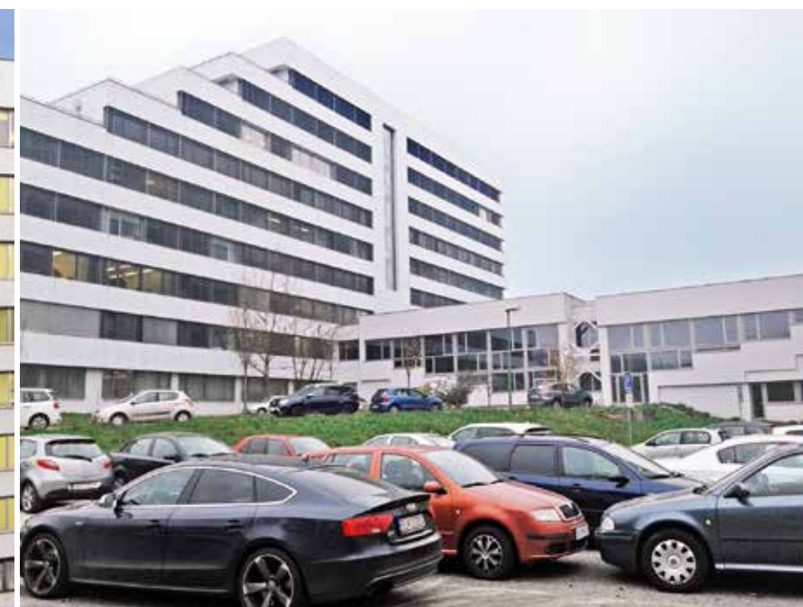
STU – FEI pred a po obnove fasády, bloky B,C,D,E
