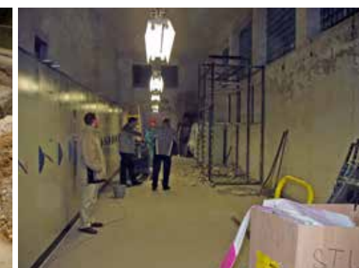
Modernizácia TS 578 – práce aj v nočných hodinách
