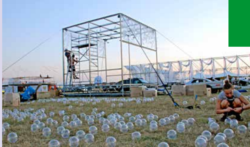
Konštrukcia už stojí, členovia tímu vešajú na ňu gule
