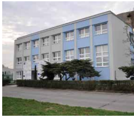
Laboratórium vysokých napätí po zateplení.
