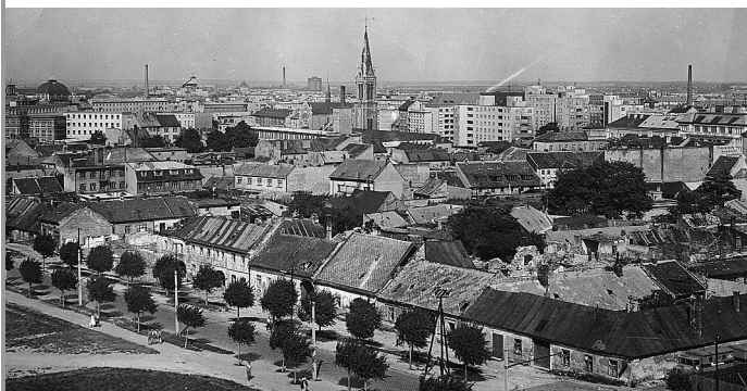
Námestie slobody pred výstavbou areálu STU
