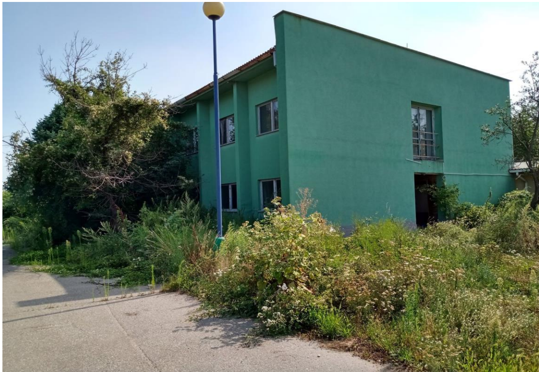
Foto 5: náletové dreviny v okolí budovy
