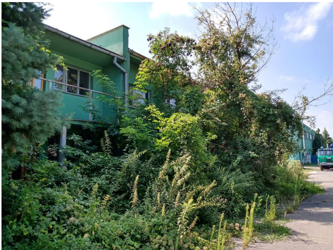
Foto 6: náletové dreviny v okolí budovy
