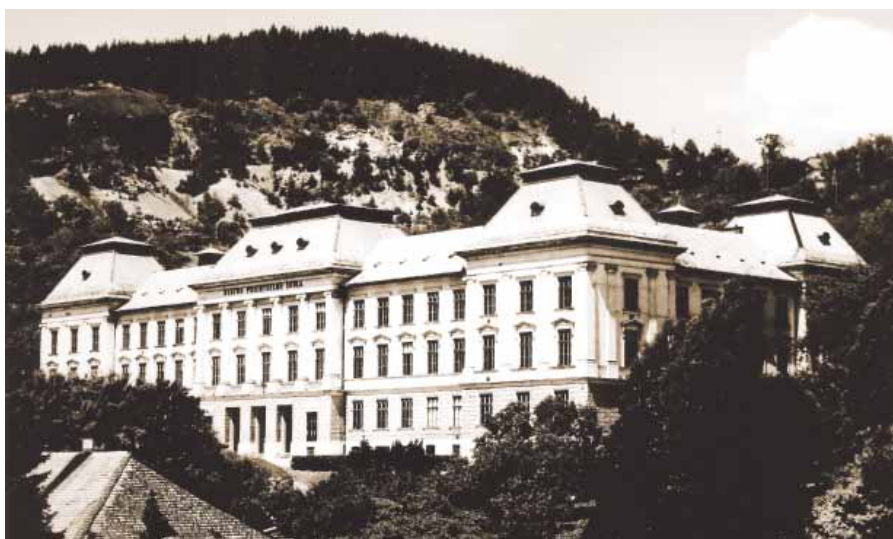
Budova Banskej a lesníckej akadémie v Banskej Štiavnici postavená v roku 1892.
