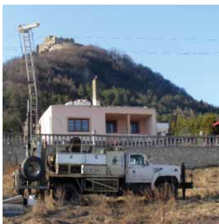
Poškodené domy pod hradom v Kapušanoch.
