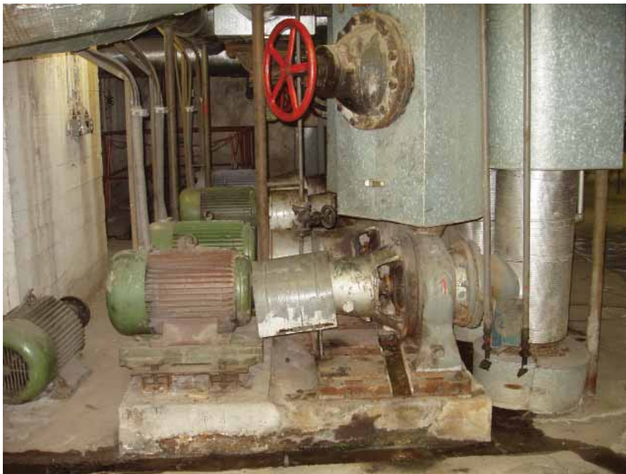
Miestami zatopené obehové čerpadlá boli hlučné a v havarijnom stave.
