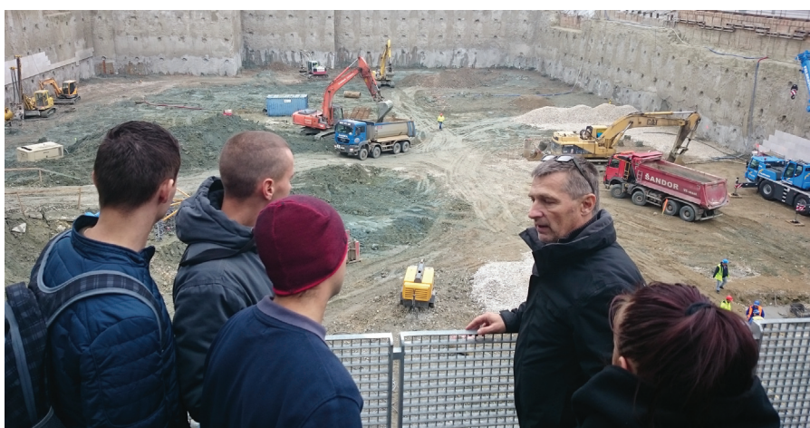
Administratívny komplex Westend Plaza – výstavba podzemných podlaží projektu.
