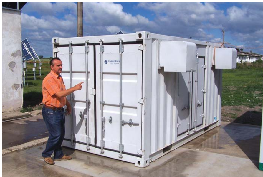
Kontajnerové vyhotovenie vanádievej batérie umožňuje rýchlu inštaláciu, a zároveň poskytuje ochranu pred vplyvmi prostredia.
