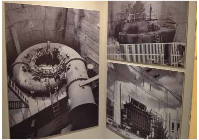
Hydroelektrárň v regióne Santa Giustina.
