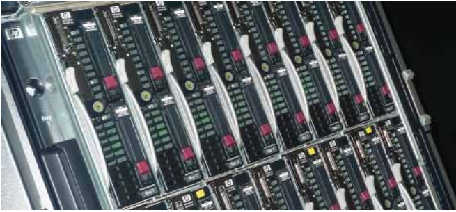
Klaster počítačov projektu SMART na ÚI SAV
