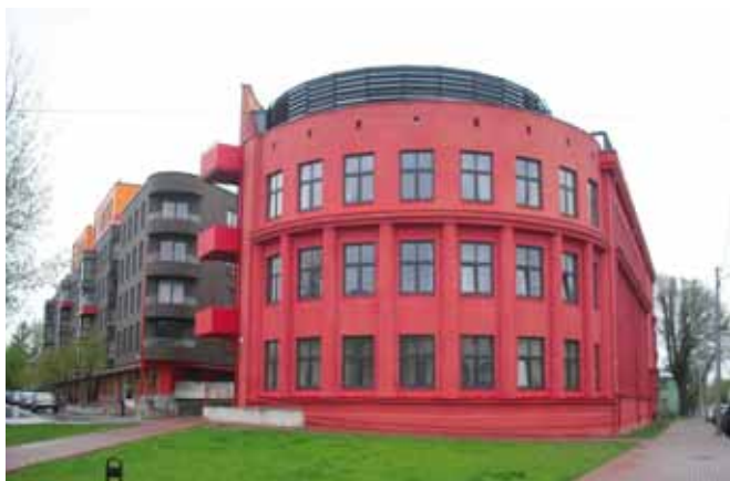
Bytové domy, ktoré vznikli revitalizáciou nábytkárskej fabriky.
