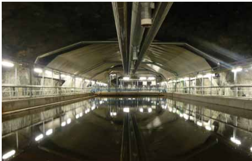
Čistiareň odpadových vôd Bekkelaget v podzemí.
