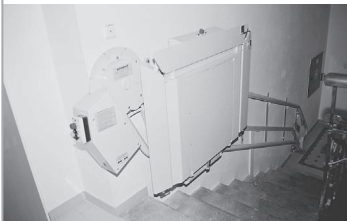
Bezbariérový prístup do budovy zabezpečuje posuvná plošina.
