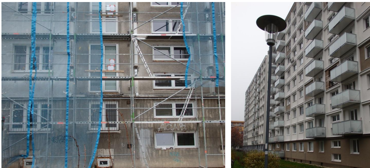
Obrázok č. 3: Niektoré domy sa rozhodli v rámci obnovy pre nové, zavesené balkónové konštrukcie, čím získali väčšiu plochu balkónov. Bratislava.
